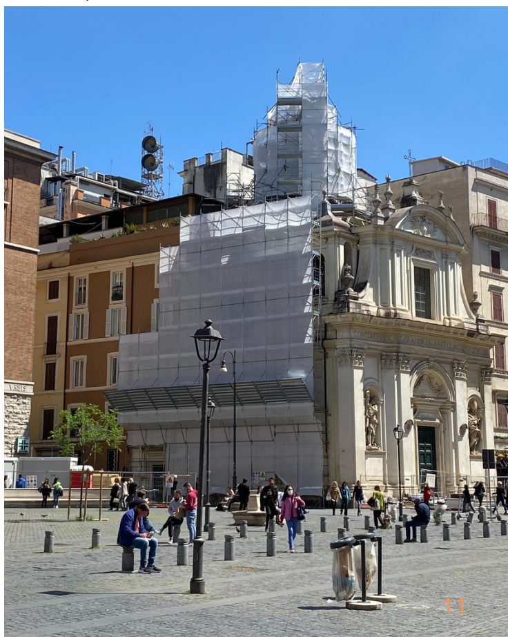
Ci-dessous, l'église Saint-André-et-Saint-Claude-des-Francis-Comtois-de-Bourgogne, en travaux, vue depuis la place San Silvestro. © PEFRL.
